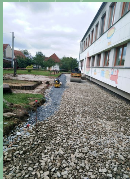
Oprava příjezdové cesty v MŠ
