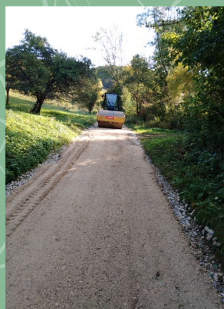
Opravená cesta do Rybníka
