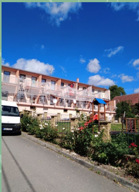
Oprava fasády a balkonů v bytovém domě
