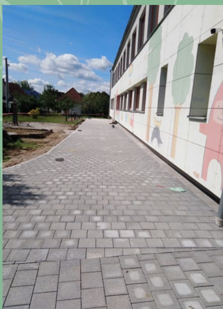
Oprava příjezdové cesty v MŠ
