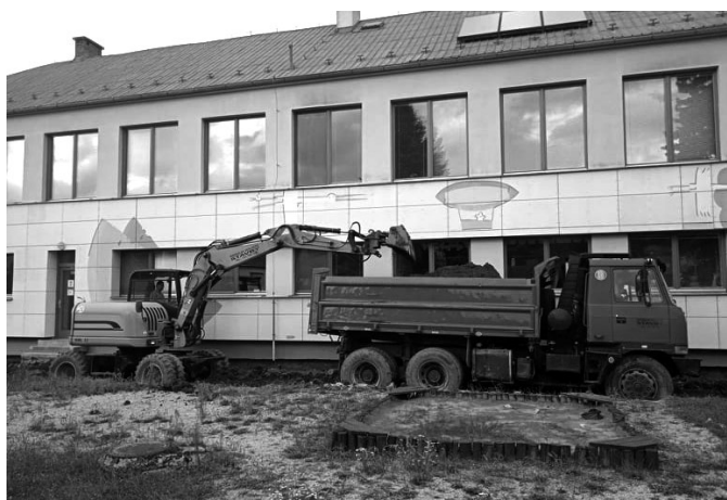
Rekonstrukce příjezdové cesty
