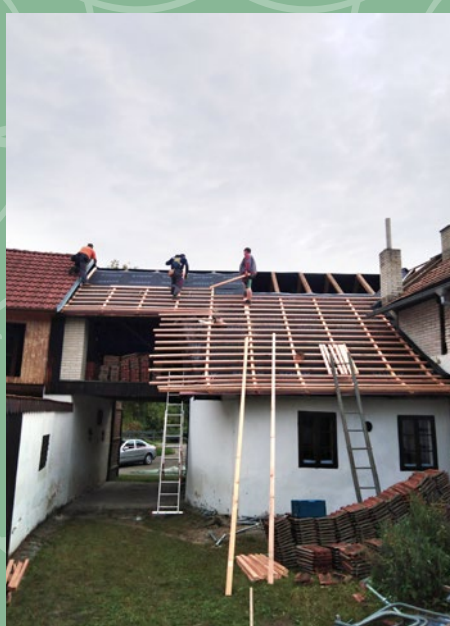
Rekonstrukce střechy muzea
