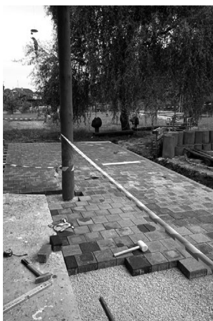
Rekonstrukce příjezdové cesty
