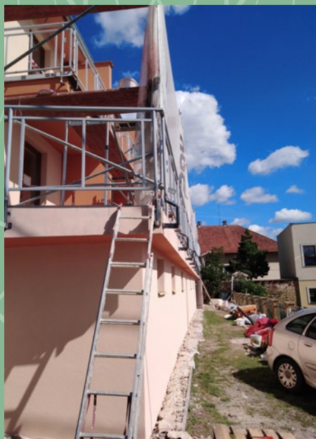
Oprava fasády a balkonů v bytovém domě
