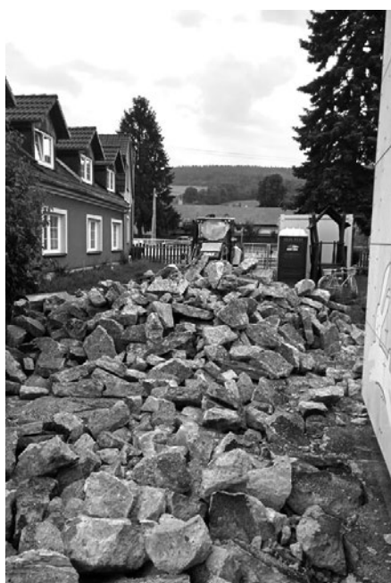
Rekonstrukce příjezdové cesty
