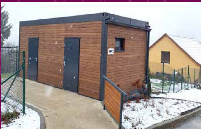
Sanitární kontejner u hřbitova
