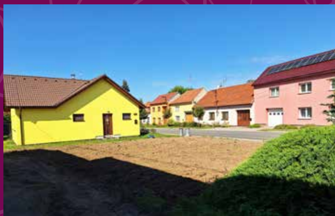
Demolice čp.157 – po
