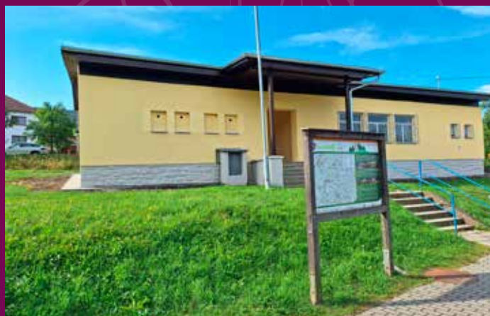
Opravená zastávka ČD
