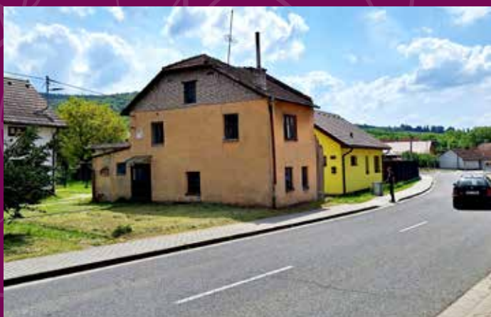
Demolice čp. 157 – před
